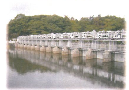
写真：十六橋水門
